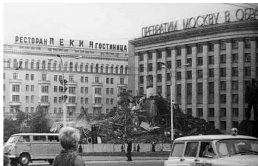
Снос театра «Современник» на площади Маяковского
