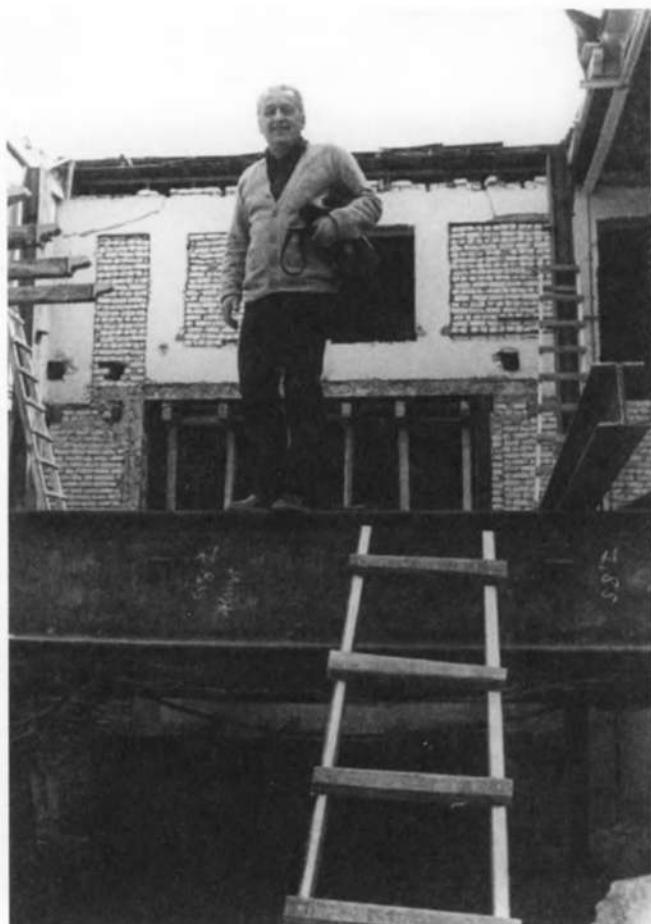
На строительстве второго театра
