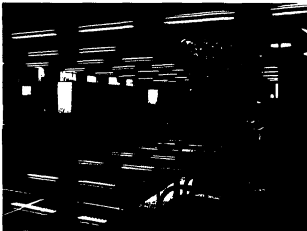
Рис. 14.2. Осветительная установка с высоким уровнем отраженной блескости
