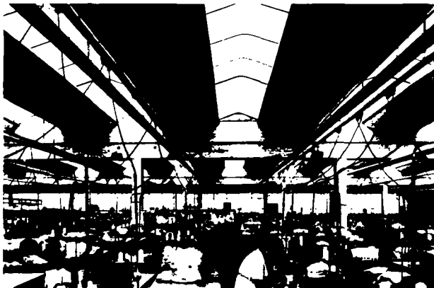
Рис. 18.8. Зенитные ленточные фонари (вид изнутри)
