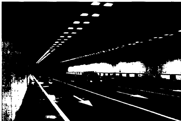
Рис. 15.72. Встречная система освещения в пороговой и переходной зонах
