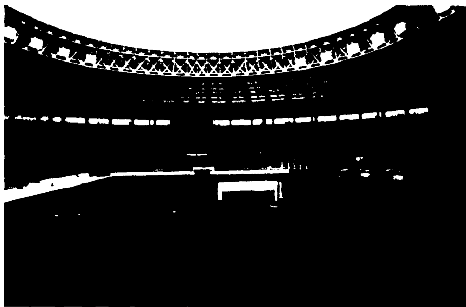
Рис. 14.49. Линейная система освещения стадиона (Большая спортивная арена Олимпийского комплекса «Лужники» в г. Москве)
