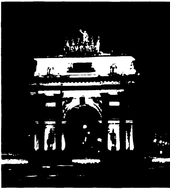
Рис. 13.60. При освещении Триумфальных арок на Кутузовском проспекте в Москве (А) и площади Шарля де Голля в Париже (Б) использован один и тот же прием. Прожекторы установлены в подземных нишах. Кроме того, в арке на Кутузовском проспекте на светлом фоне стены силуэтно просматриваются статуи римских легионеров
