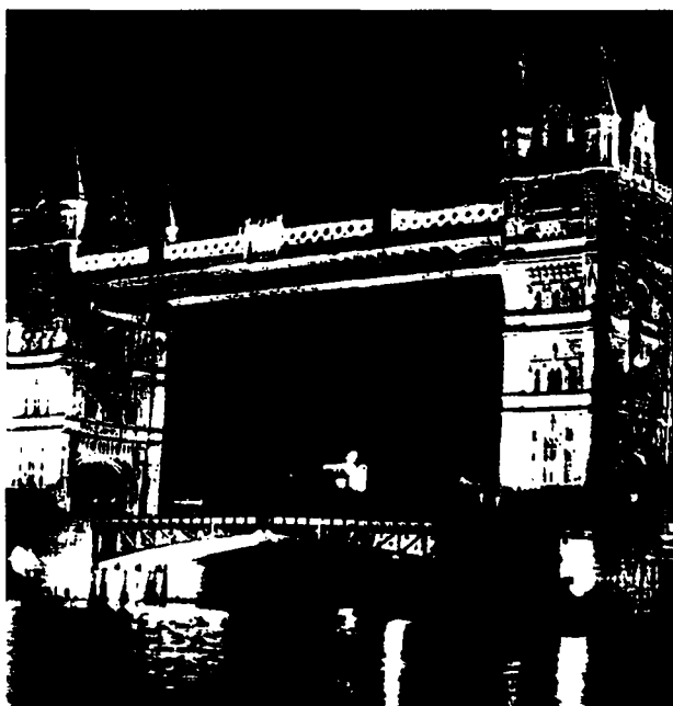
Рис. 13.44. Мост Тауэр через р. Темзу в Лондоне. Основной прием: заливающий свет снизу вверх от ОП, установленных на набережной и в основании моста
