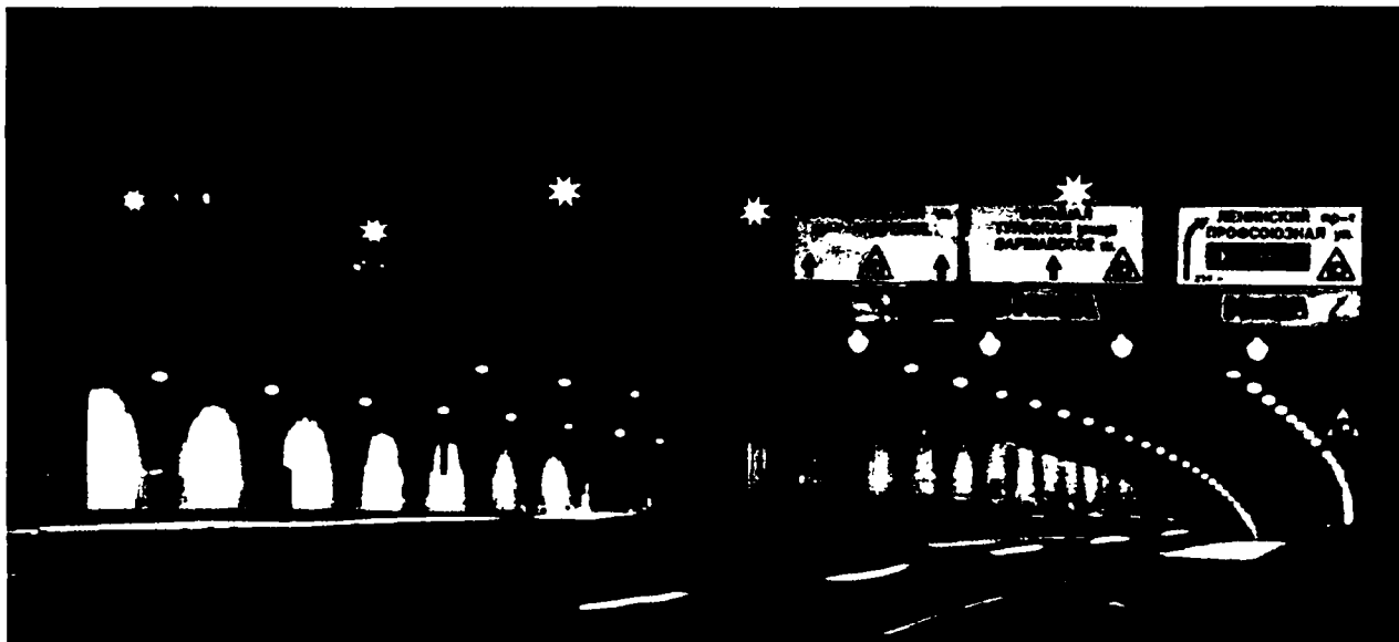
Рис. 15.64. Общий вид въезда в туннель
