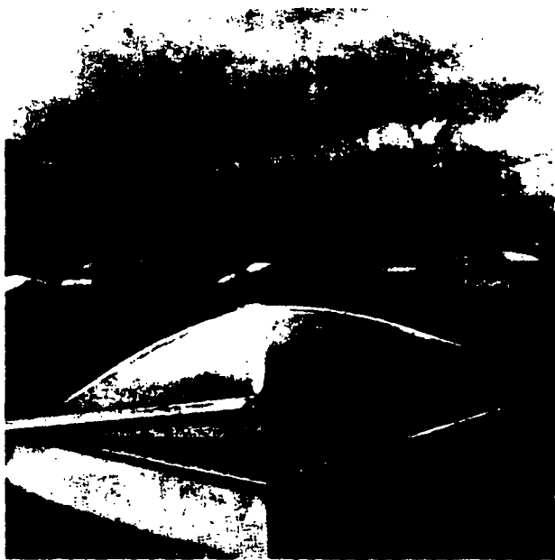
Рис. 18.11. Зенитные точечные купола с системами дистанционного открывания для аэрации
