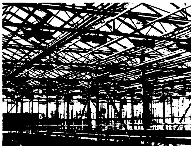
Рис. 16.43. Облучательная установка с лампами-светильниками ДНаЗ
