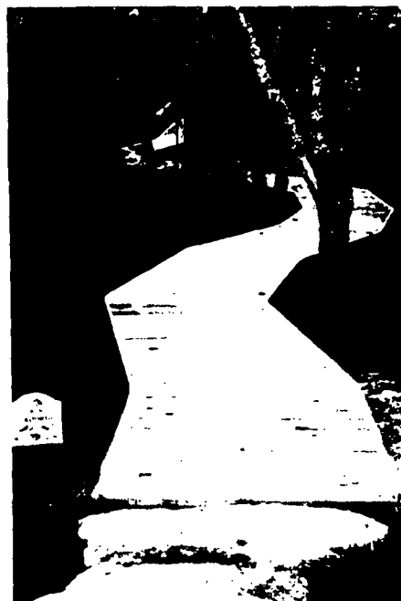
Рис. 6.49. Применение световодов с излучающей боковой поверхностью для освещения прогулочной дорожки
