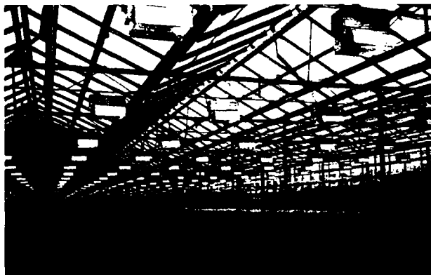
Рис. 16.38. Фрагмент теплицы с лампами типа НЛВД, располагаемыми под блоком ПРА
