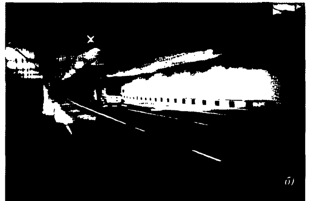
Рис. 15.73. Симметричная система освещения во внутренней (а) и выездной (б) зонах
