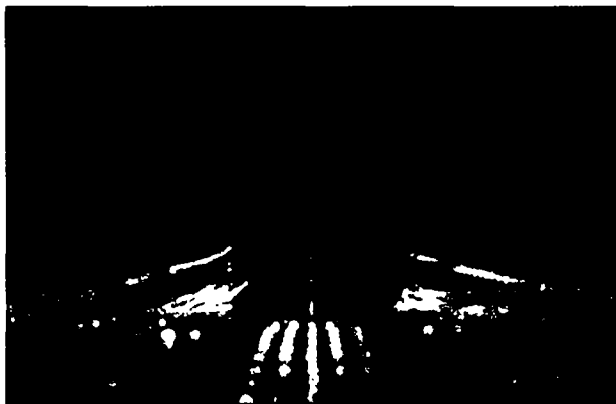
Рис. 17.40. Процесс посадки ВС на ВПП со светосигнальными огнями: на переднем плане — слева и справа красные огни КПБ; в середине — белые огни центрального ряда КПБ; на дальнем плане — огни ВПП
